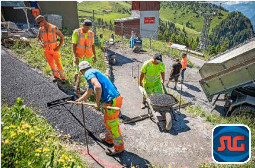
Planieren, Belag verteilen, Verbundsteine fräsen: Die Lernenden haben in die Hände gespickt und professionelle Arbeit geleistet.
